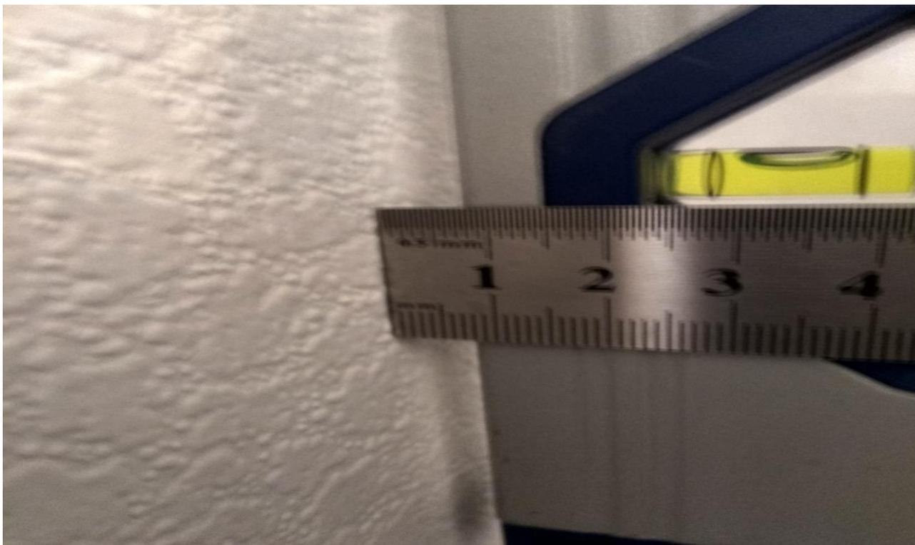
10. Дверное полотно в сан-узле площадью 5,11 м. кв., имеет отклонение от уровня дверного блока в 6 мм., *Фото №16.*
